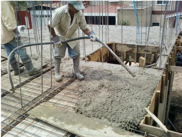
Figura 2.20 Colado de losa. [10]
