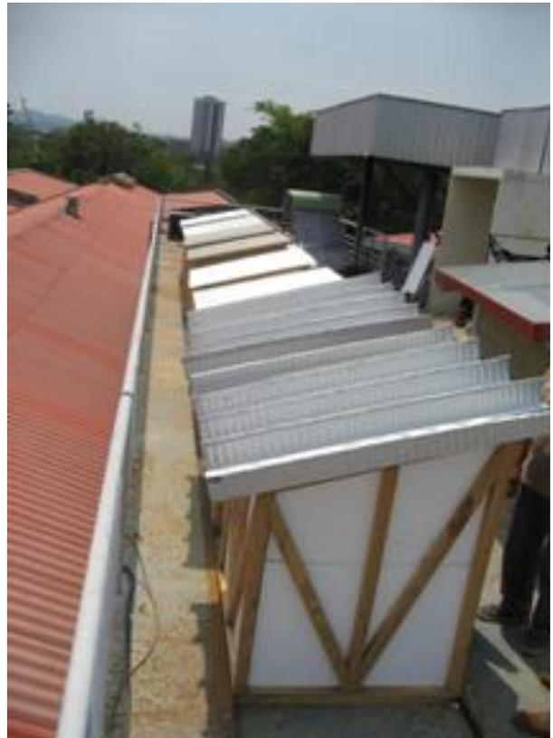
Figura 4.14 Montaje de cubiertas sobre módulos de prueba.
