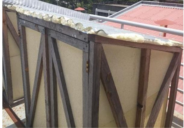
Figura 5.11 Aplicación de espuma aislante en techo de fibrocemento.
