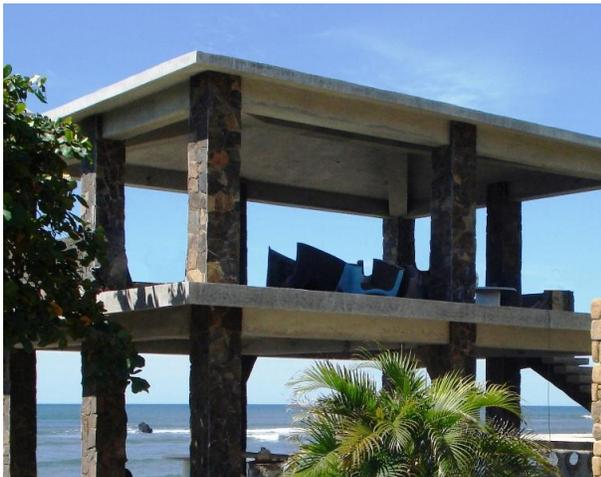
Figura 2.21 Losa aligerada de techo. [10]
