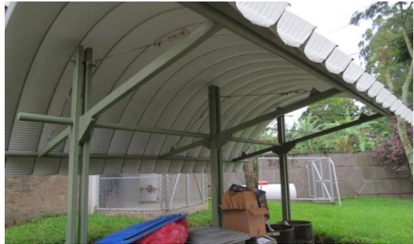
Figura 2.22 Techo de estación con lámina auto-soportante. [10]
